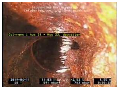
Bildnamn: 1_2_A, Videotid: 28s Grenrör, klockan 03.
