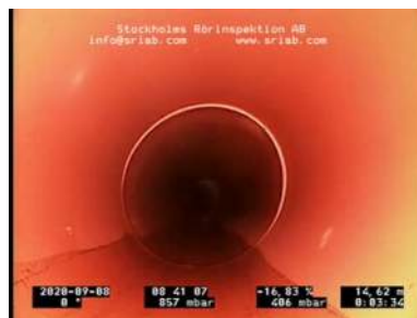
Bildnamn: 3_9_A, Videotid: 214s Deformation 1. Mindre än 5 % av rörets diameter.
