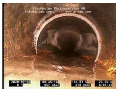
Bildnamn: 3_11_A, Videotid: 405s Fogförskjutning 2. Radiell fogförskjutning där knappt rörets hela godstjocklek Vattenansamling 2. Medför en vattennivå som är från 5 % och upp till 15 % av rörets invändiga höjd.
