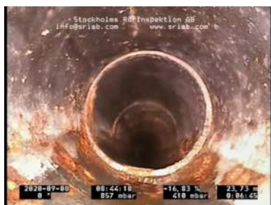
Bildnamn: 3_11_A, Videotid: 405s Fogförskjutning 2. Radiell fogförskjutning där knappt rörets hela godstjocklek Vattenansamling 2. Medför en vattennivå som är från 5 % och upp till 15 % av rörets invändiga höjd.
