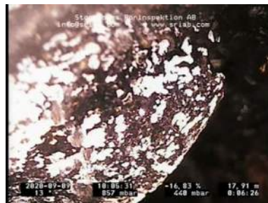
Bildnamn: 3_9_A, Videotid: 386s Främmande föremål 2. Reduktion av rörets tvärsnittsarea som är från 5 % och upp till 15 %.
