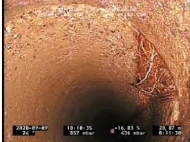
Bildnamn: 3_12_A, Videotid: 690s Inläckage 3, klockan 04 , rinnande.
