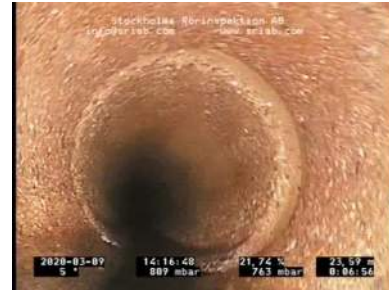
Bildnamn: 1_10_A, Videotid: 416s Fogförskjutning 2. Radiell fogförskjutning där knappt rörets hela godstjocklek är synlig.
