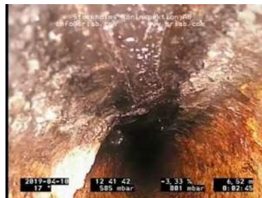
Bildnamn: 1_5_A, Videotid: 165s Främmande föremål 2. Reduktion av rörets tvärsnittsarea som är från 5 % och upp till 15 %.
