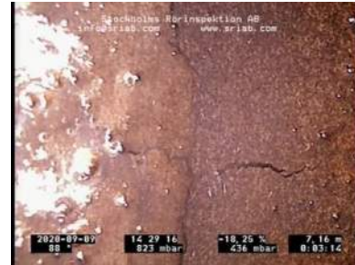
Bildnamn: 1_4_B, Videotid: 153s Sprickor 1. Ytsprickor, klockan 08 , utspridda.
