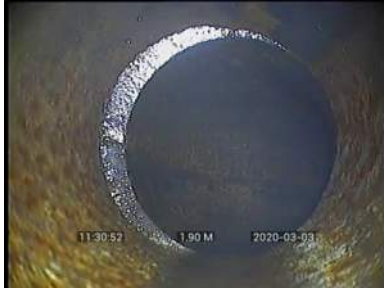
Bildnamn: 8_3_A, Videotid: 15s Fogförskjutning 2. Radiell fogförskjutning där knappt rörets hela godstjocklek är synlig.
