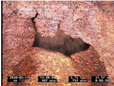
Bildnamn: 2_18_A, Videotid: 468s Grenrör, klockan 12.
