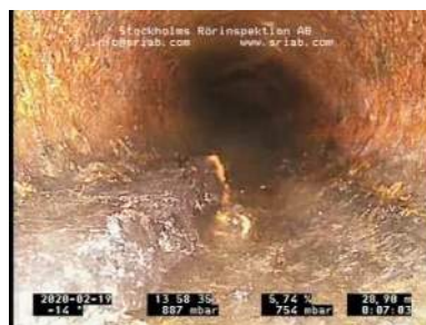
Bildnamn: 2_17_A, Videotid: 423s Främmande föremål 2. Reduktion av rörets tvärsnittsarea som är från 5 % och upp till 15 %.
